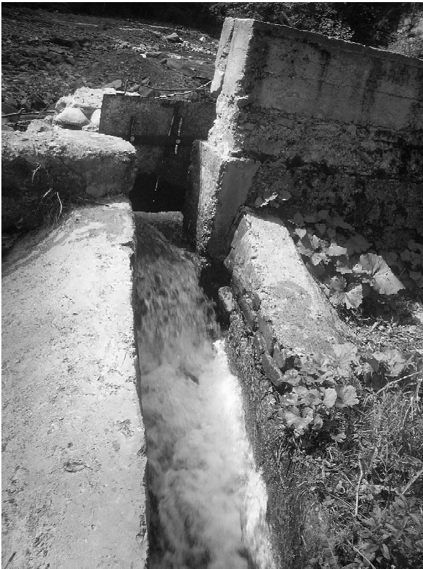
Рис.1. Дірчаста перегородка між секціями басейну
