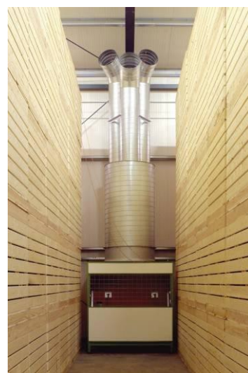
Малюнок1. Припливно-витяжна вентиляція на картоплесховищі.
