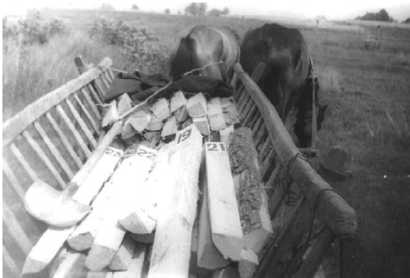
Рис.130. Доставка дерев'яних стовпів на об'єкт для закріплення точок
