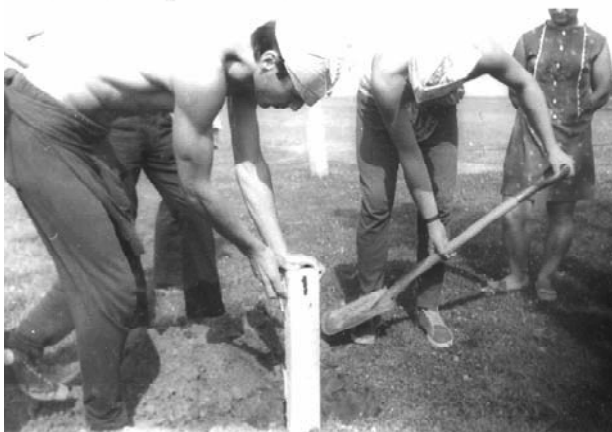
Рис.135. Закріплення основних точок кривої
