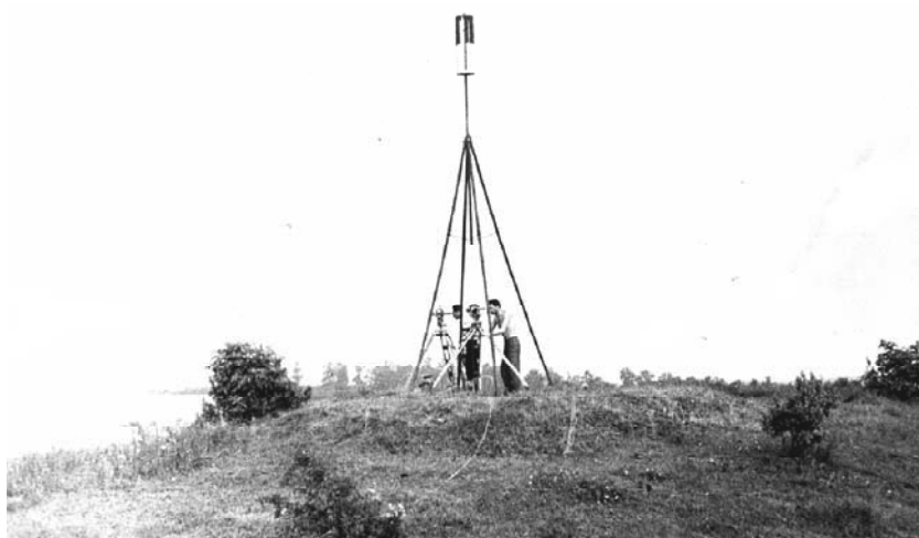
Рис.70. Прив'язка теодолітних ходів до пунктів старших класів
