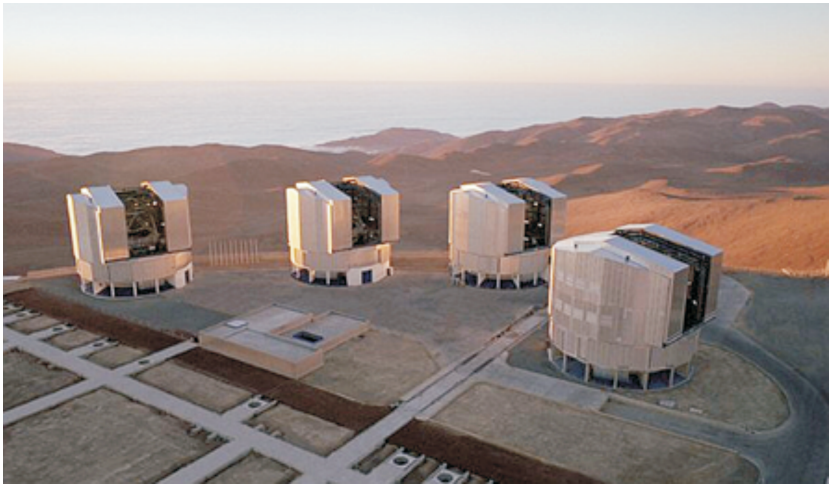
Рис. 7. Інтерферометр із 4-х Дуже Великих Телескопів Європейської Південної обсерваторії, розташованої на горі Серро Параналь (Чилі, висота 2635 м). Діаметр дзеркала кожного телескопа – 8,3 м. За роздільною здатністю цей інтерферометр еквівалентний дзеркалу діаметром 130 м.
