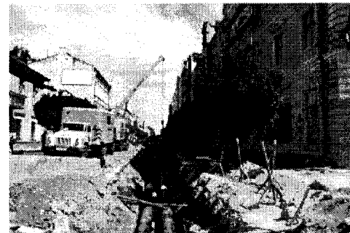
Роботи з реконструкції центральної частини міста
