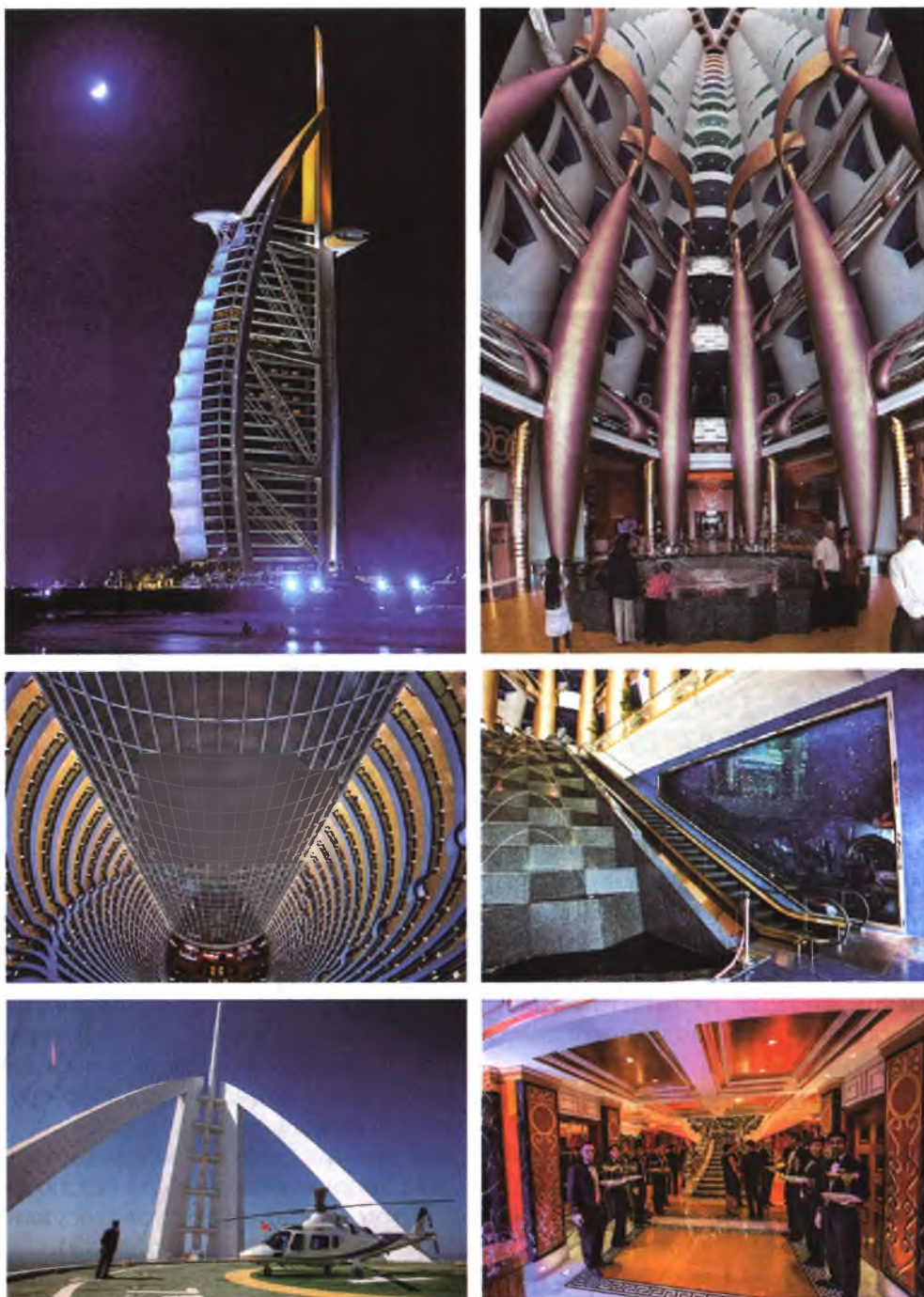
Рис. 39. Бурдж-ель-Араб. Дубай. 1999 р. Архіт. Том Райн. Загальний вигляд, інтер'єри вестибюля і майданчик для гелікоптера на даху готелю
