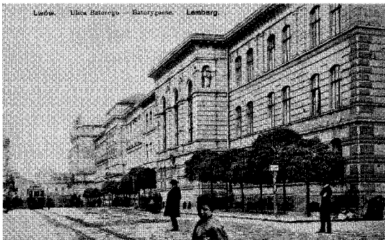
Ц.-к. прокуратура на вул. Баторія
