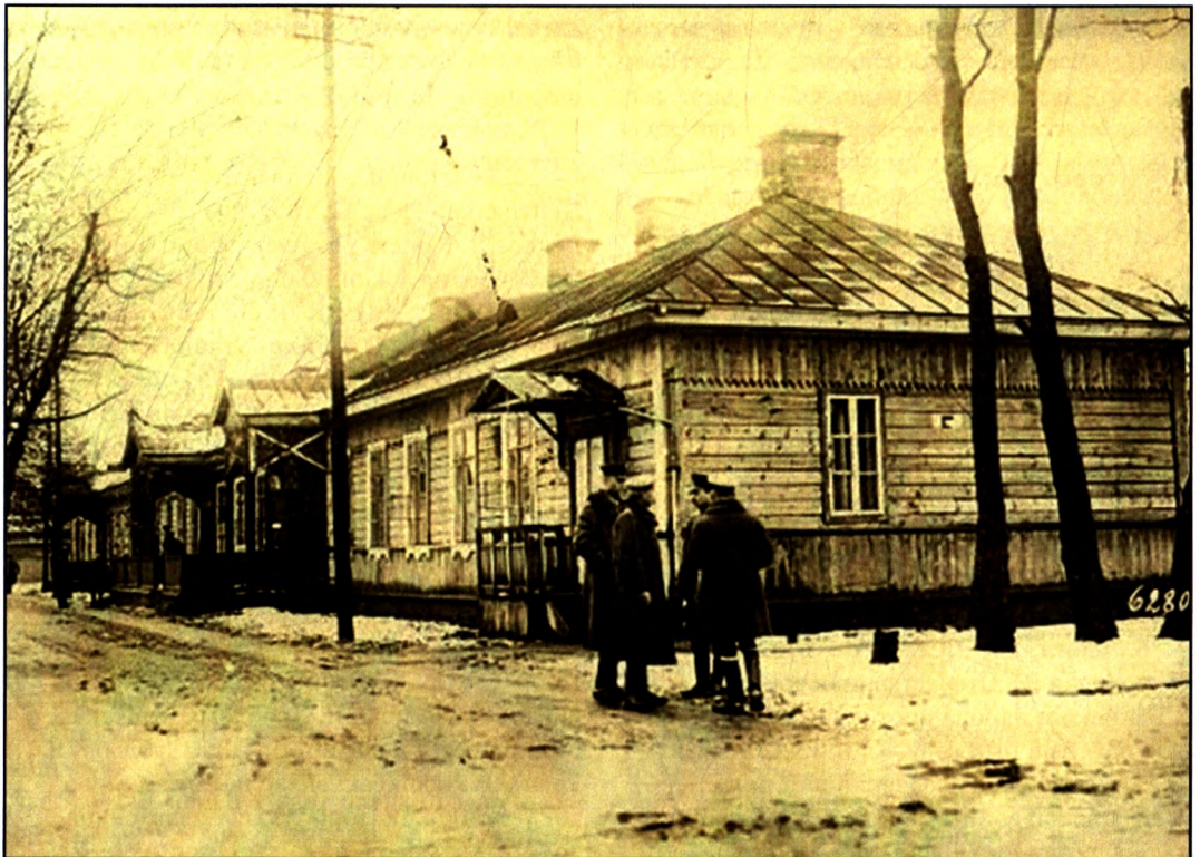
У цій будівлі тривали перемовини і було підписано Брестський мирний договір http://www.istpravda.com.ua/articles/2018/02/16/152083/
