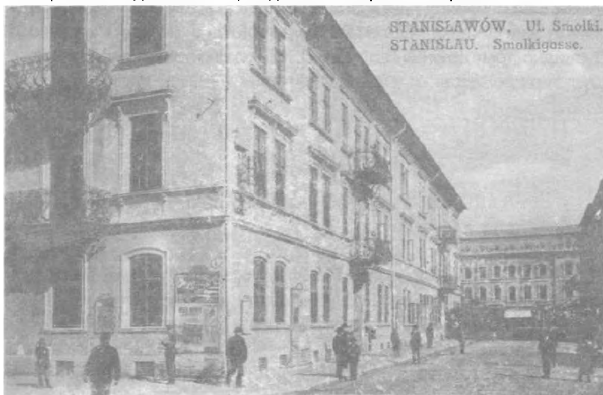
Будинок першої телефонної станції (на передньому плані)
