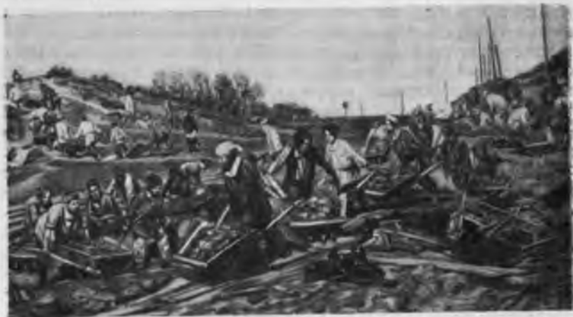
Ремонтные работы на железной дороге. С карт. К. Савицкого.
