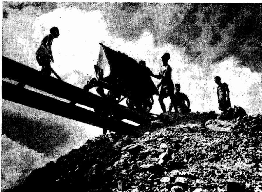
Строительство железнодорожной линии Перник (Димитрово)—Волюяк
