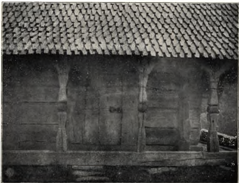
Рис. 13. Опоясане на сішках кругом церкви в с. Бистрім біля Стройни.
