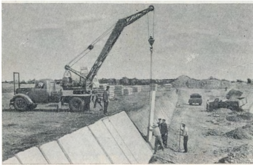
Будівництво силосної траншеї в Озернянському колгоспі «Комуніст». 1965 р.
