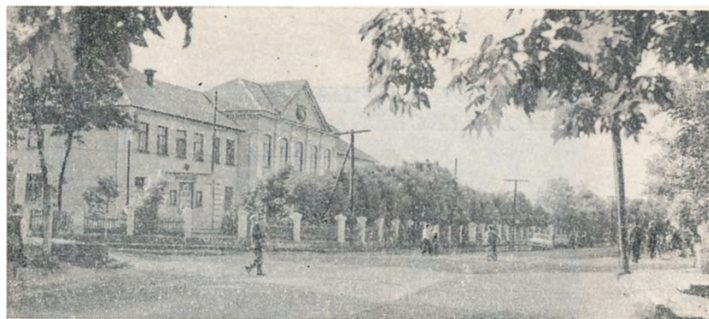
Центральна вулиця Березані. 1970 р.
