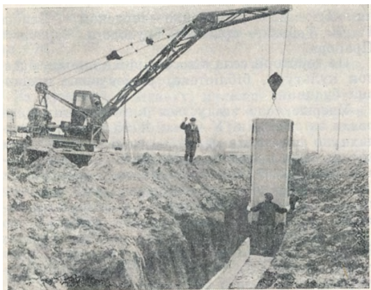
Будівництво теплотраси в Єрківському колгоспі ім. Горького. 1969 р.
