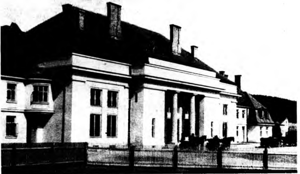
Фото із зб. М. Дем'янчука Будинок залізничної станції в Делятині
