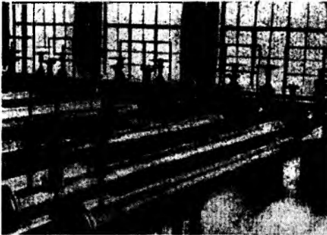
Газопровід Дашава - Київ, газорозподільна станція
