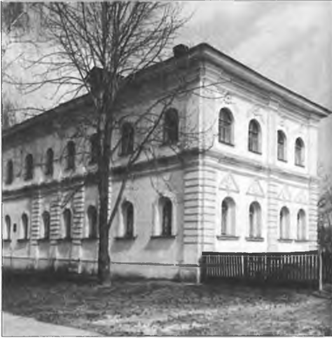
Козелець. Будинок полкової канцелярії. 1753—1758 рр.
