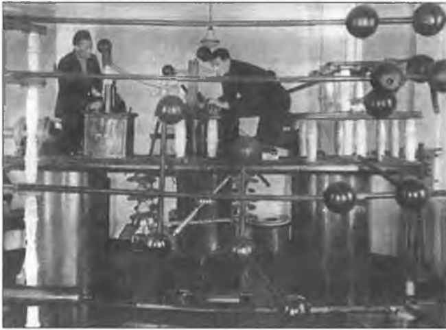
Роботи по вивченню атомного ядра в Харкові, в УФТІ. Генератор постійного струму на 1,4 млн вольт
