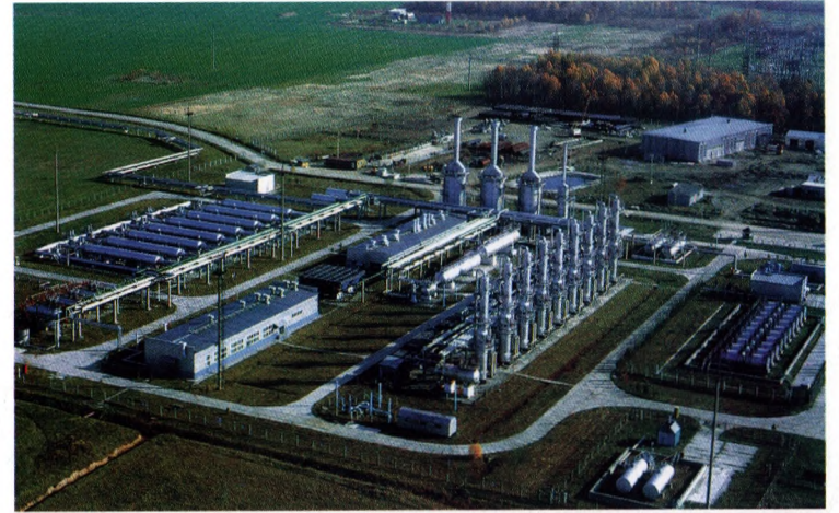
△ Газокомпресорна станція в смт. Богородчани
