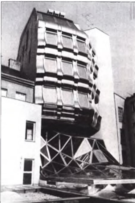
Будинок центральної ощадної каси у Відні. Архітектор Г. Доменінг (1979)
