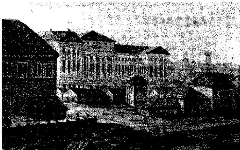
Здание Московского университета на Моховой улице.
