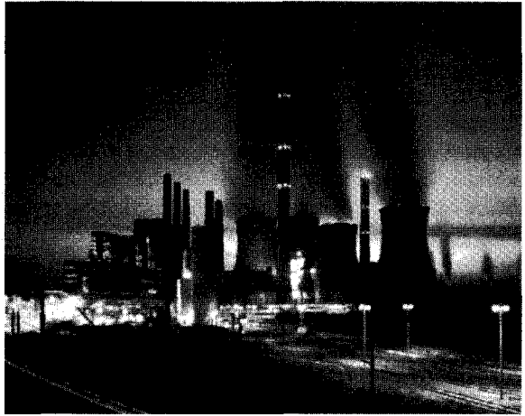
Das Braunkohlekraftwerk in Grevenbroich-Neurath
