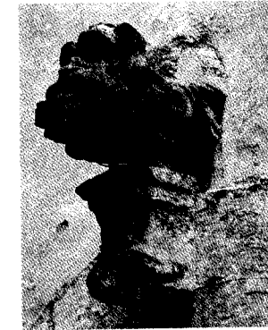
269. Готичне завершення кам'яної водозливної ринви (так званого ригача). XV ст. Вапняк. Львів, вул. Руська, 4.
