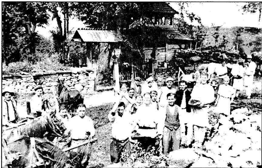
Початок будівництва церкви Св. Миколая. Заготівля каменю для фундаменту. 1938 р.
