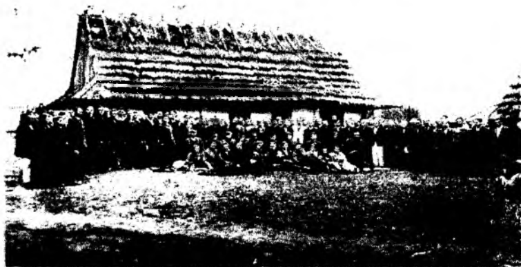
Свято зброї в с. Яблунів Турківського району Львівської області. Серпень 1944. Присілок Ясенів. Спереду напівлежить у військовій формі районний провідник ОУН "Юрій" (Кишаневич). Загинув 19.02.1945.
