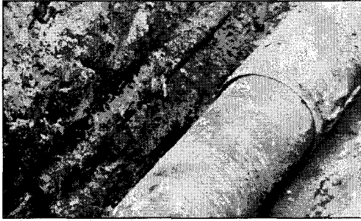
Дерев'яний водопровід початку ХІХст. по вул. Валовій (на передньому плані — сучасний водопровід). Світлина І. Кочкіна.
