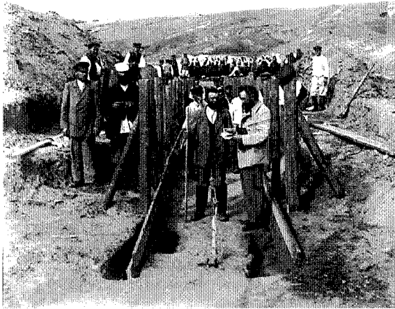
Будівництво залізниці у др. пол. XIX ст. в Полтавській губернії
