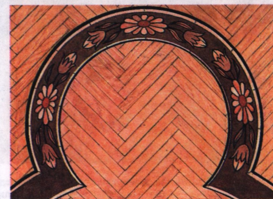
Рис. 33. Декоративное украшение букового паркетного пола. Интарсия, контурная резьба с заполнением мастикой, тонирование. План контура орнамента пола для комнаты с размерами 5,5х3,2 м
