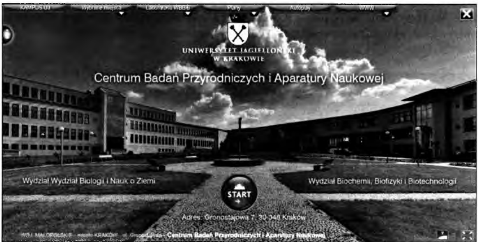
Rysunek 3. Budynek Wydziału Biologii i Nauk o Ziemi i Wydziału Biochemii, Biofizyki i Biotechnologii przy ul. Gronostajowej 7
