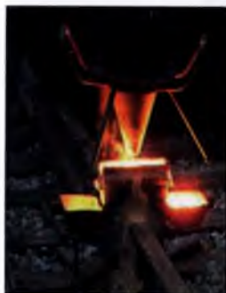
Мал. 100. Зварювання рейок за допомогою термітної суміші
