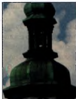
Мал. 85. Продукти корозії на мідному покритті храмового купола
