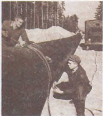
Будівництво газопроводу Шебелинка–Острозька. 1960 р.
