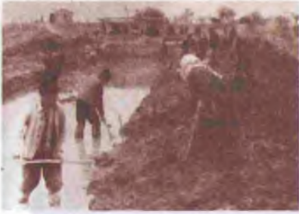
Будівництво іригаційної системи. Одещина. 1949 р.
