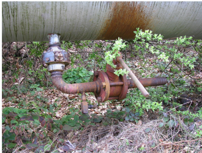
Рис. 3. Врізка запірної арматури в газопровід для дренажу рідини.
